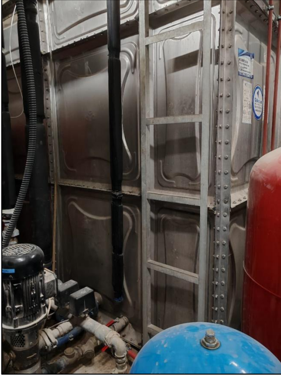
Su Deposu Temizliği
